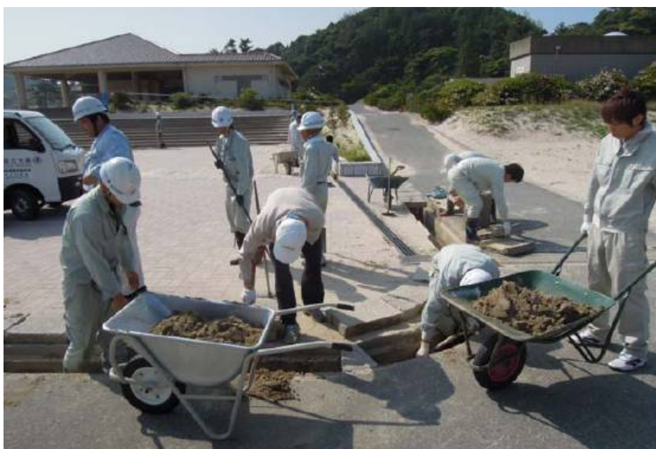
浜田地区の石見海浜公園ビーチハウス周辺における作業状況
