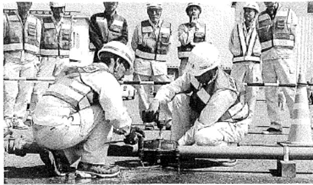
水道管の応急復旧訓練をする会員=松江市内
