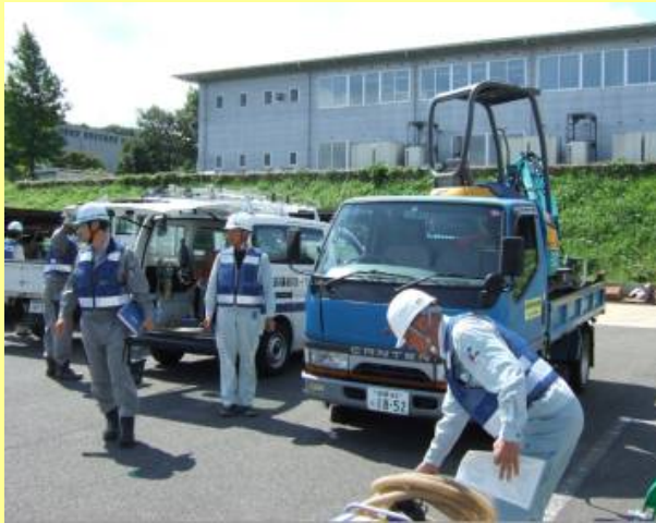
配管応急復旧模擬訓練
